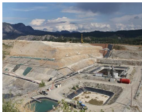
Centre d'enfouissement de Ventavon
