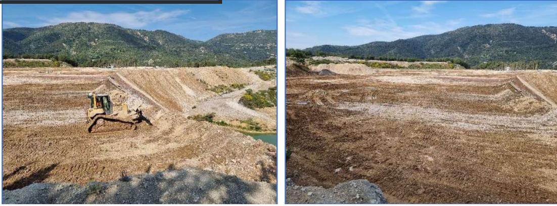
Déblaiement des tas d'inertes vers talus – trainées de régalage des tas d'inertes sur la plateforme (avant poussage)
