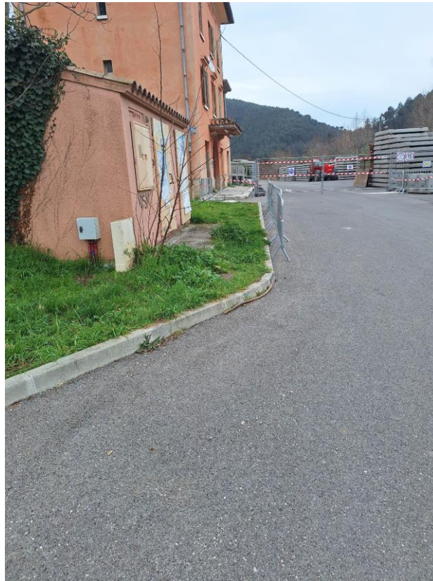
Figure 3 : Photographie de la bordure côté est (vue du nord du parking)
