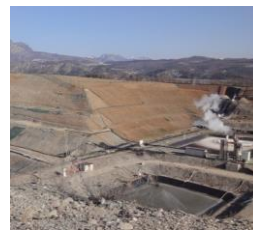
Centre d'enfouissement de Ventavon
